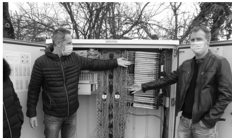
Ein sabotierter Schaltschrank in Frankreich. Infrastruktur wie diese erhält das Netzwerk der Herrschaft und unsere Isolation aufrecht.
